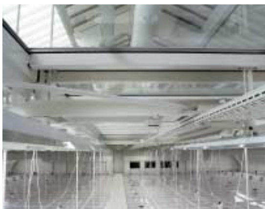
Blick in den komplexen Dachaufbau des grossen Pfistersaales mit Beleuchtung, Beschattung mit Grosslamellen und Lüftung.
