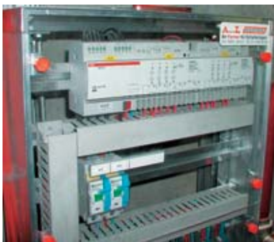
Dezentral platzierte EIB-Komponenten
