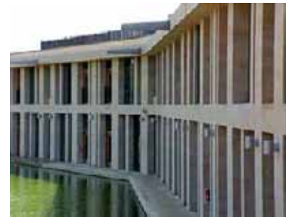
Das SciTec-Zentrum der Oundle School vereint Wissenschaft, Kunst und Technik und wurde mit zukunftsgerichteten nachhaltigen Technologien wie KNX erbaut
