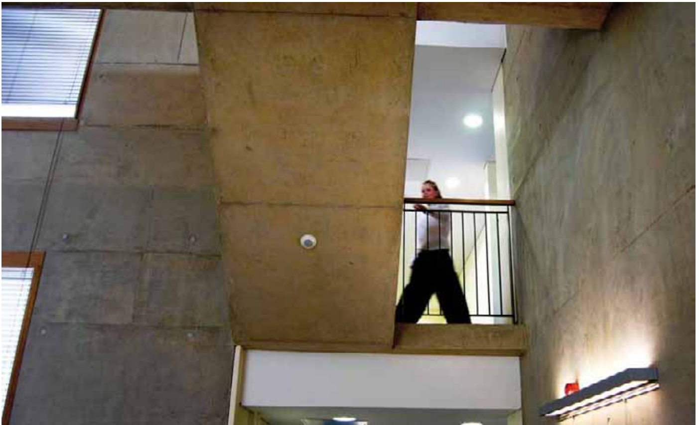
Energieeffizienz 2: viel Tageslicht und Präsenzmelder für die Beleuchtung.
