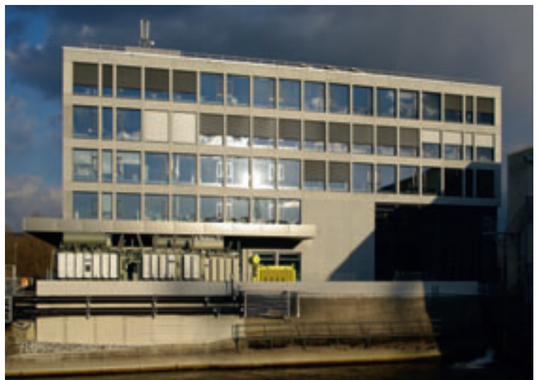
Eine intelligente Sonnenschutzsteuerung gewährleistet im Sommer kühle Büros ohne Klimaanlage und nutzt im Winter Sonnenkraft für die Raumheizung.
