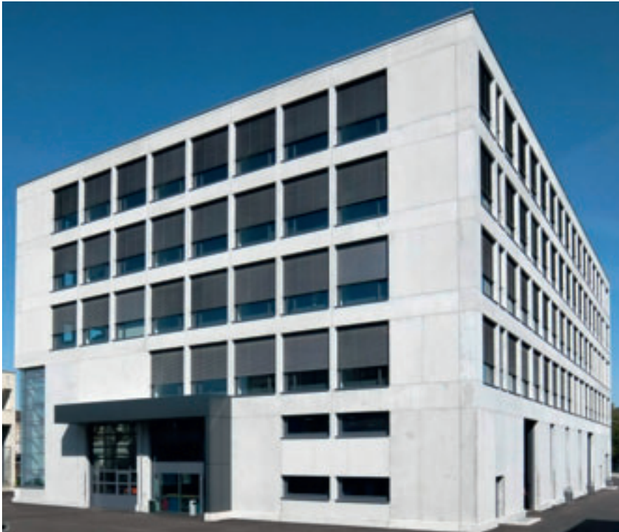
Der Neubau von EKZ Eltop in Dietikon beherbergt die Trafowerkstatt und Büros.
