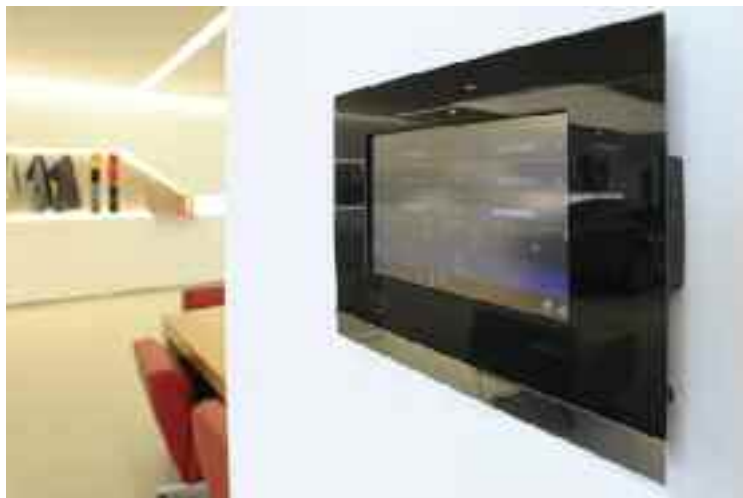
Appareil de commande ABB-priOn pour la gestion et la variation de l'éclairage des show-rooms.
