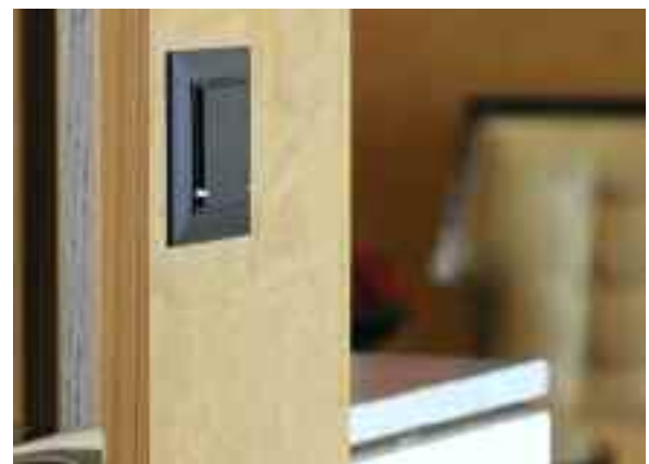
Matériaux nobles et éclairage généreux dans le spa. Poussoir KNX ABB Sidus: accès local à l'éclairage.
