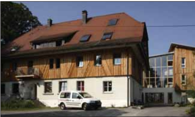
Bild 2. Hinter dem älteren Wohnhaus befindet sich die Schule, deren Gebäudetechnik von der Firma Schwägler betreut wird / Fig. 2. Behind the older house is the school, whose building engineering is cared for by the company Schwägler.
