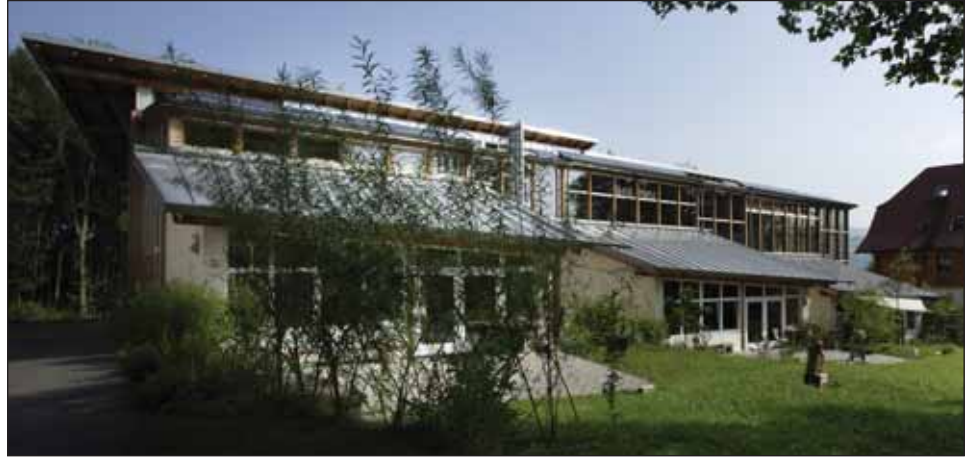
Bild 1. Die Rückansicht des Schulgebäudes bietet einen Eindruck von den riesigen Fensterflächen, die lüftungstechnisch gemanagt werden müssen. Dazu versorgt eine Wetterzentrale auf dem Dach die zentrale Steuerung mit Daten. / Fig. 1. The back side of the school building give an impression of the large window areas, which must be managed by the ventilation system. A weather station on the roof supplies data to the central control system.
