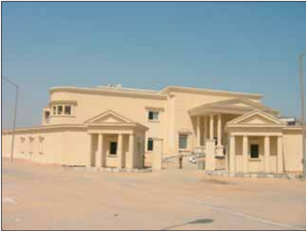
Bild 1. Blick auf die herrschaftliche Villa mit KNX Steuerung in der Nähe von Kairo Figure 1. View of the manorial villa with KNX control near Cairo
