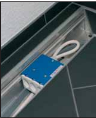
Bild 2. Bodenkanäle ermöglichen jederzeit das Nachrüsten von Anschlüssen Figure 2. Floor conduits allow later retrofits
