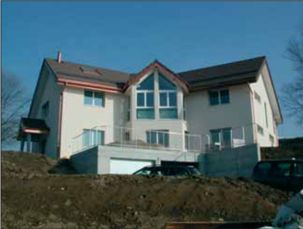
Bild 1. Das Einfamilienhaus in Puidoux mit hoher Energieeffizienz dank KNX Figure 1. Single family home in Puidoux with high energy efficiency due to KNX
