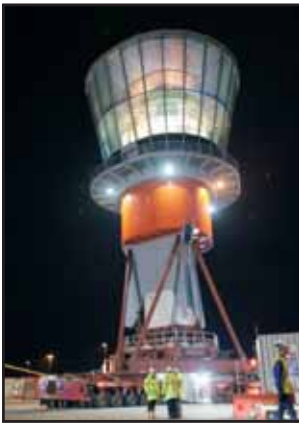
Bild 3. Teile des Controltowers auf dem Weg zu seinem Standplatz Figure 3. Parts of the control tower on its way to the project site
