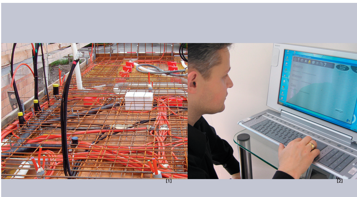
[1] Gredig Decke des Pilotprojektes Smarthome Chur vor dem Betonieren. Bei der Verlegungen der Elektroleitungen wurde auch auf die Vermeidung von elektromagnetischen Feldern («Elektrosmog») geachtet. Foto: Gredig
