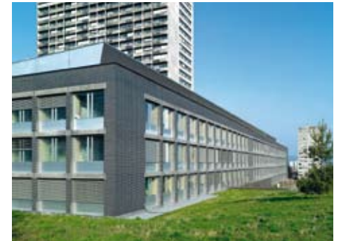
Automatisme intégral des bâtiments et locaux. Hôpital de la ville Triemli, Zurich
