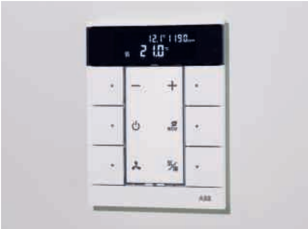
Une seule unité de commande règle la température ambiante, la teneur en CO 2 , les stores et l'éclairage.
